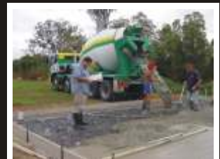
Pouring the slab
